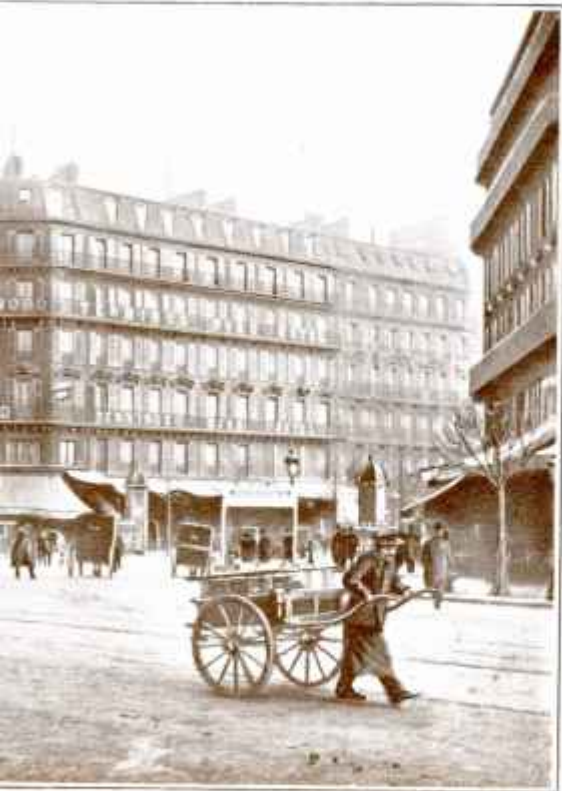
M. J.-M. Mureau, Architecte à Paris Elevage à vapeur - Eau chaude - Cuisines
